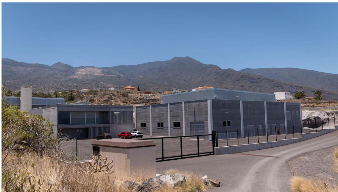
Depuradora de aguas residuales urbanas del Valle de Güímar / Arturo Jiménez
